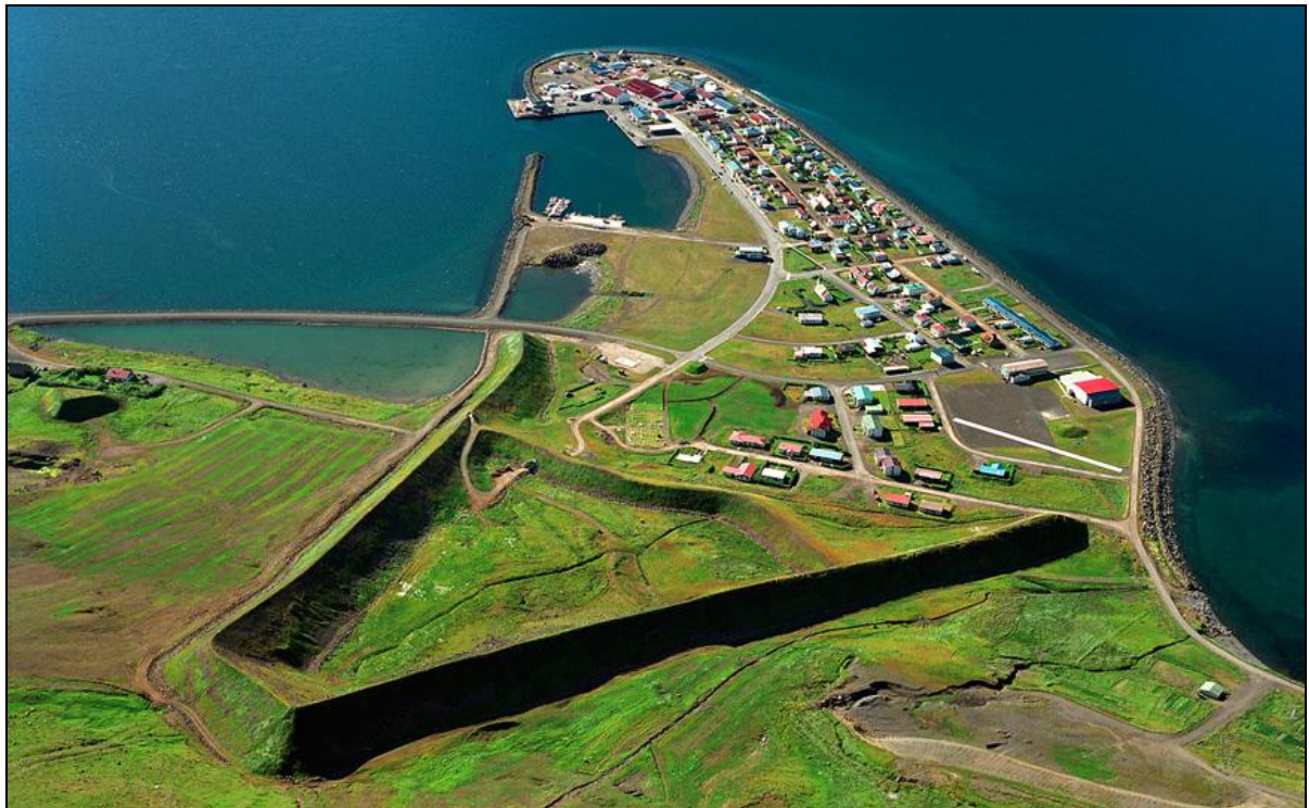
Snjóflóðavarnargarðar á Flateyri. Ljósmynd Mats Wibe Lund.
