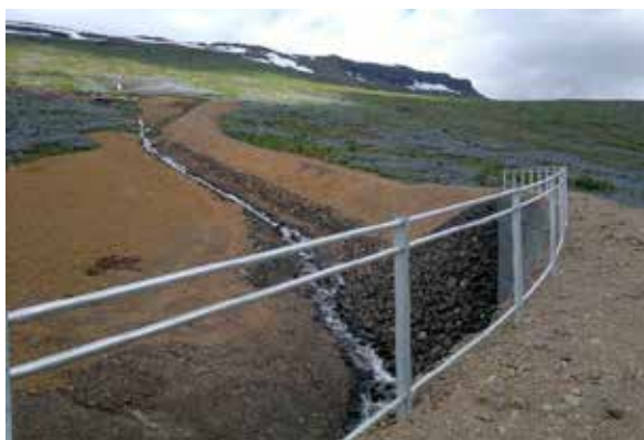
Mynd 6. Grjótstífla og leiðigarður í vinnslu. Mynd tekin frá þvergildru.
