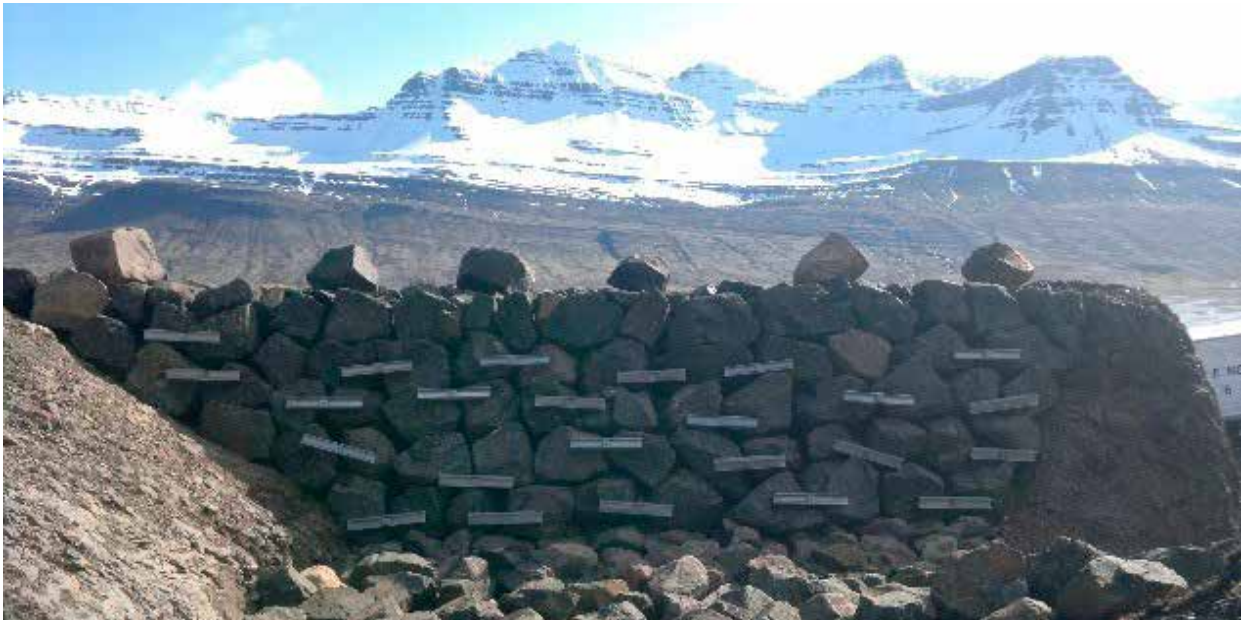
Mynd 2. Efri hluti grjótstíflu í 110 metra hæð yfir sjávarmáli.
