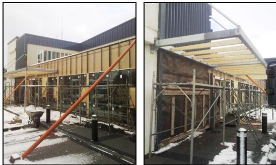
Unnið að útveggjaklæðningu og skyggni.
