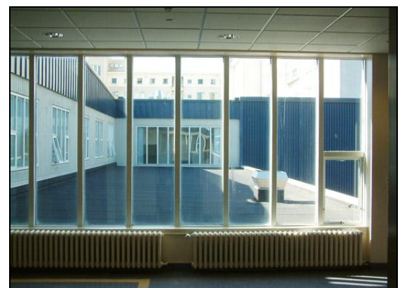
Séð út á þak nýju viðbyggingarinnar.
