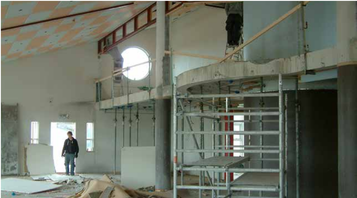
Mynd 2. Vinna við niðurrif á 2. hæð í upphafi verks.
