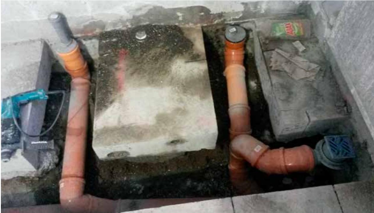
Mynd 4. Nýjar frárennslislagnir undir plötur.
