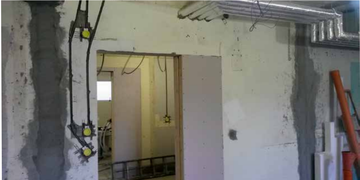
Mynd 2. Unnið að frágangi innveggja.
