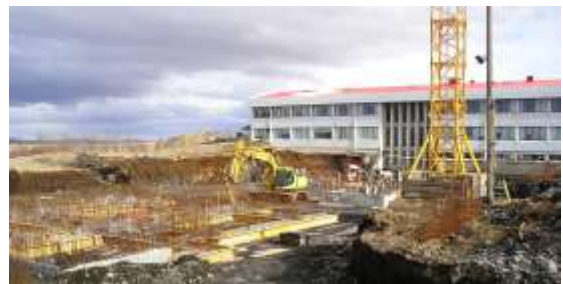
Mynd 10: Framkvæmdir við sökkla og undirstöður
