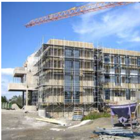
Mynd 11: Framkvæmdir á verktíma
