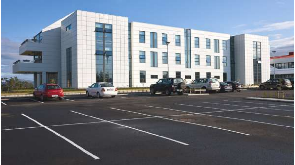
Mynd 13: Húsið fullbyggt
