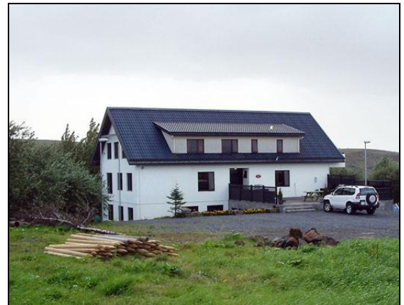
Fangelsið að Bitru, norðurhlið.
