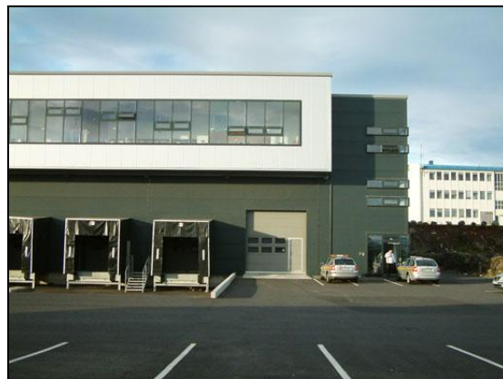
Inngangur að húsnæði Tollstjórans í Reykjavík.
