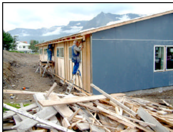
Unnið við klæðningu hússins að utan. Mynd tekin 12. ágúst 2003.
